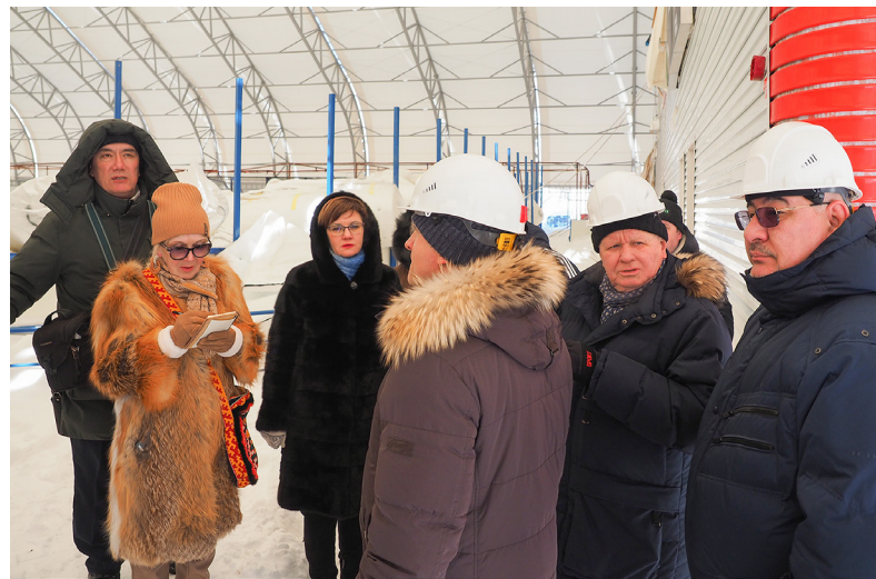
■ В результате инспекции были выявлены нарушения в технологиях, применяемых в ремонте СК «Полярный», внесены правки в текущий план работ подрядной организации. ФОТО АВТОРА
